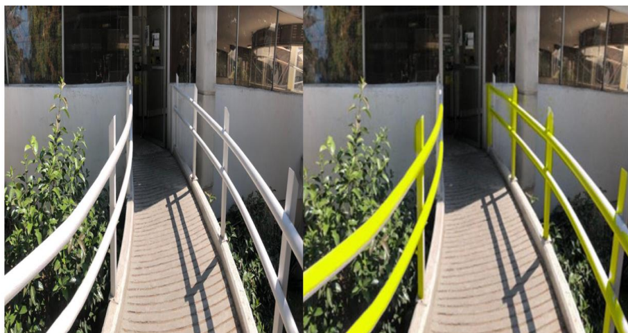
Ilustración 56, 57 Y 58. Propuesta de Señalización en la cadena de accesibilidad al área de servicio social y práctica profesional
